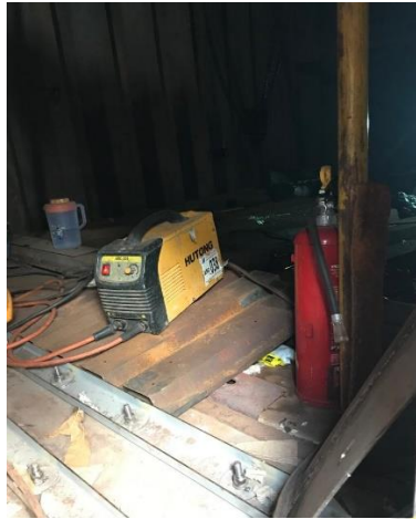
Gambar 4.3 Menyediakan APAR pada pekerjaan mengelas
