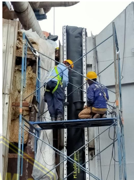
Gambar 4.8 Penggunaan Body Harness pada pekerjaan ketinggian
