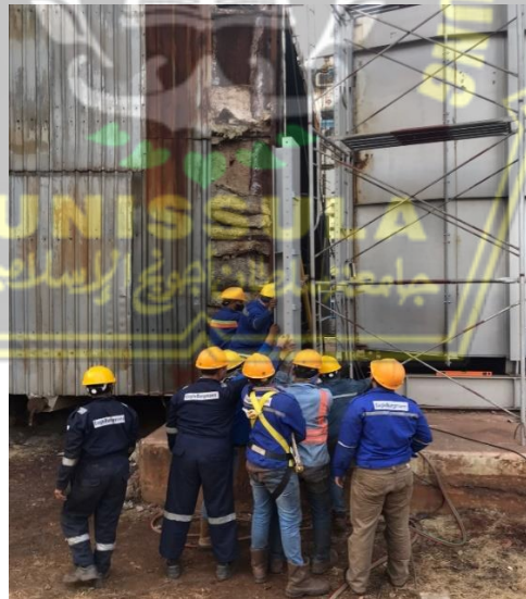
Gambar 4.2 Salah satu tahapan pekerjaan pada pemasangan Expansion Joint pada HRSG Unit 2.2
