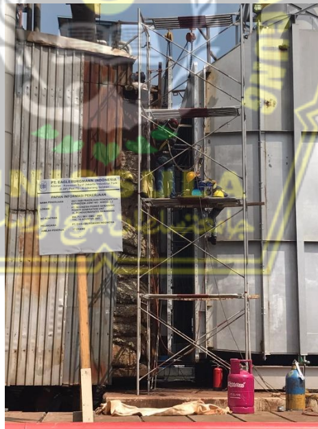
Gambar 1.2 Pekerjaan Pemasangan Plat Expansion Joint pada HRSG Unit 2.2 PLTGU Tambak Lorok Semarang (Sumber : Dokumen Pribadi/PT EagleBurgmann Indonesia)
