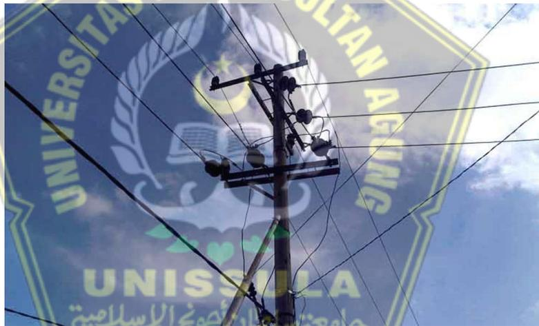
Gambar 2. 8 Saluran Udara Tegangan Menengah
