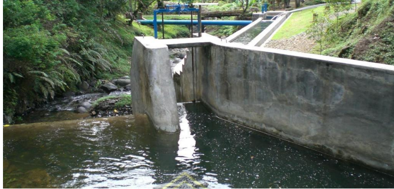
Gambar 2.1 Intake atau Dam
