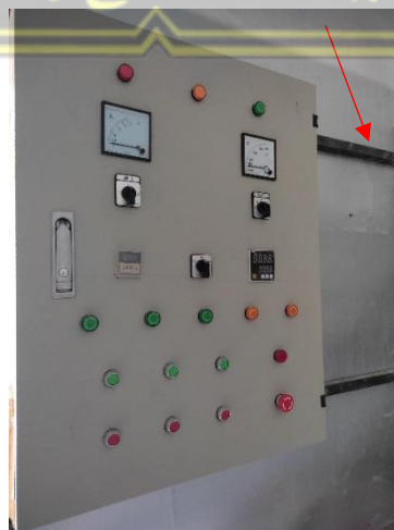
Gambar 3.18 Penambahan struktur penyangga panel kontrol
