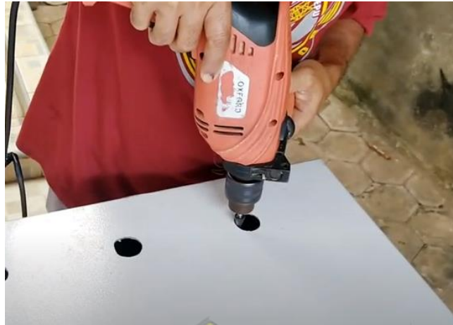
Gambar 3.13 Pelubangan Pintu Panel
