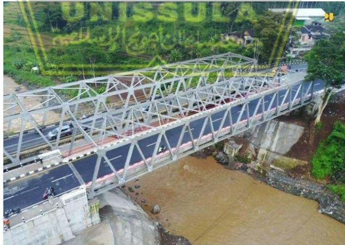
Gambar 4.1 Jembatan Progo Kranggan
