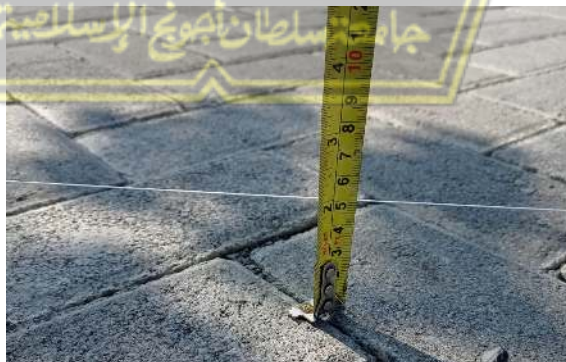
Gambar 4.14. Mengukur kedalaman rutting
