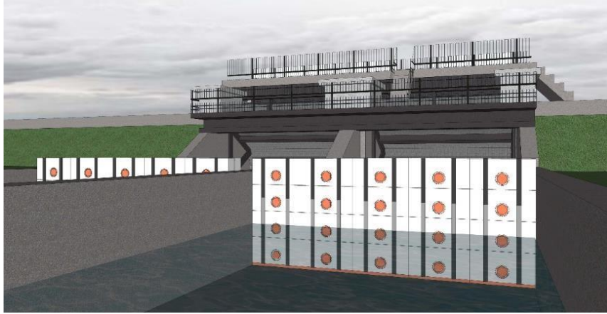
Gambar 5.21: Bendung Barrier Plastik Untuk Bendung Sungai
