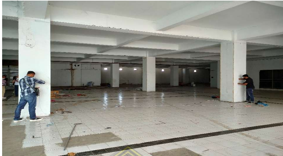
Gambar 3.10. Pengujian waterpass menggunakan selang berisi air
