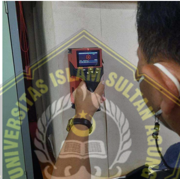
Gambar 3.14 : Pengujian rebar detector
