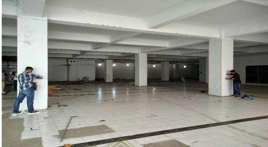
**Gambar 3.10.** Pengujian *waterpass* menggunakan selang berisi air
