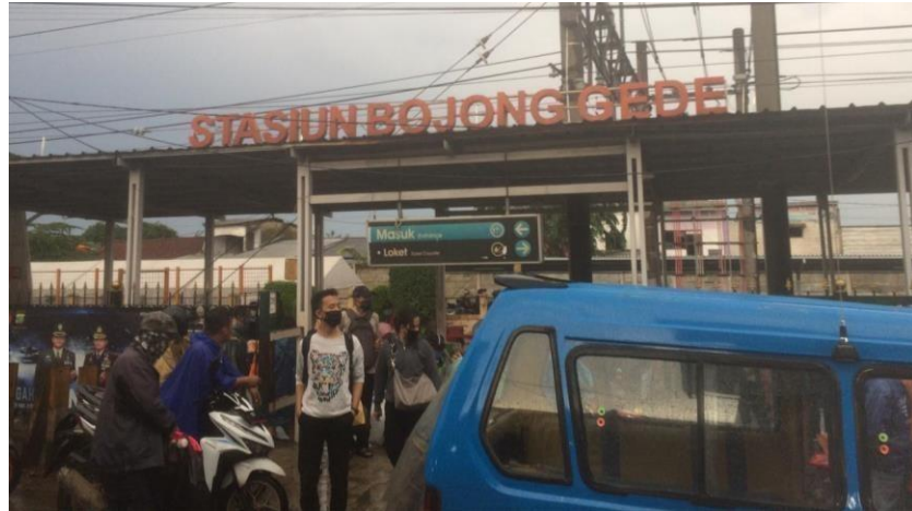
Gambar 4. 38 Kondisi Depan Stasiun Bojong Gede
