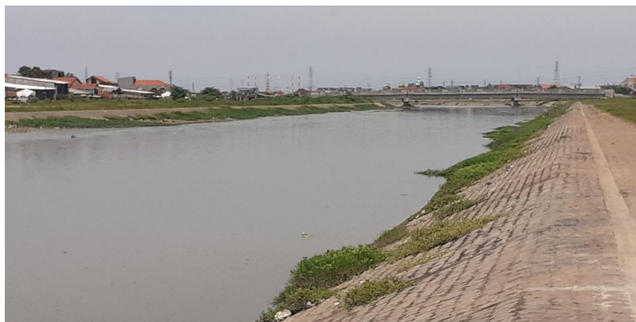
Gambar 4.85. Struktur Revetment STA 2+550
