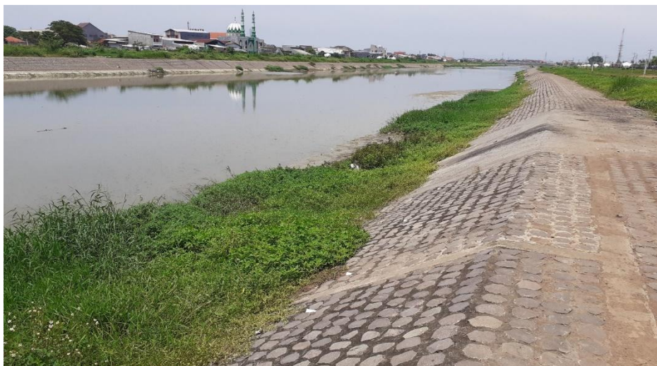
Gambar 4.76. Struktur Revetment STA 3+600 dalam kondisi baik
