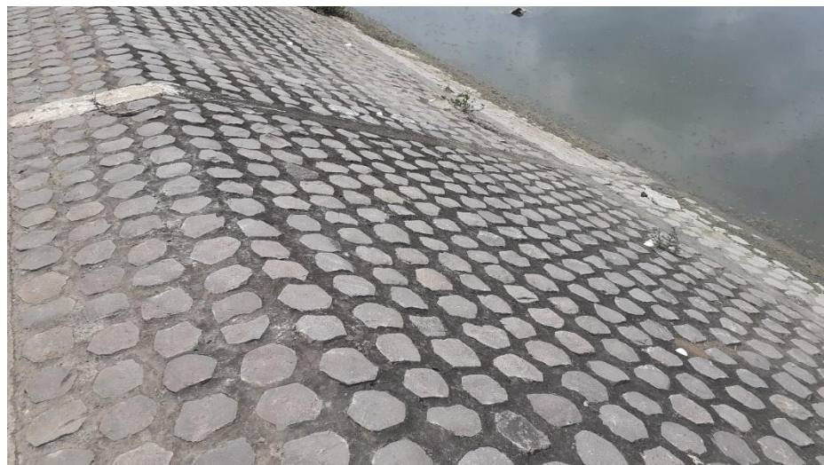
Gambar 4.82. Struktur Revetment STA 2+750
