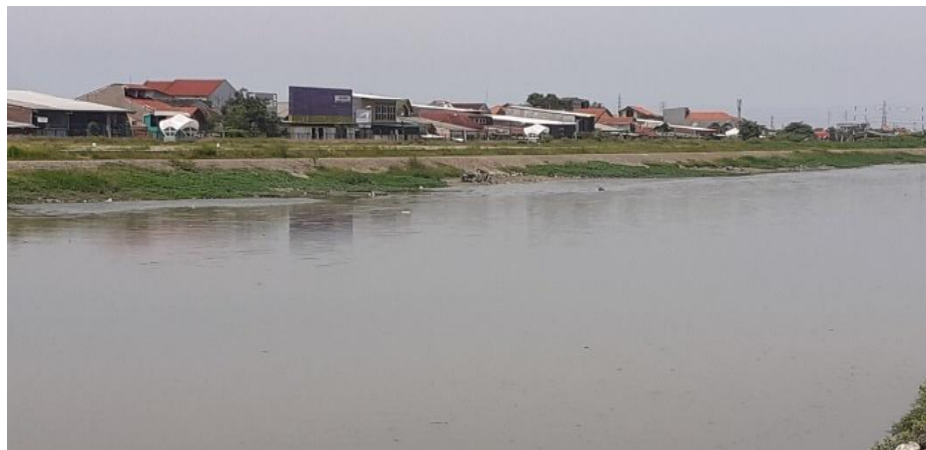
Gambar 4.84. Area Sedimentasi STA 2+550
