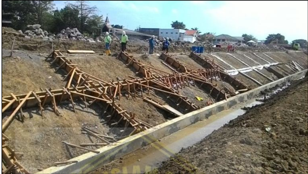
Gambar 2.11. Struktur Revetment Sumber: Pelaksanaan Konstruksi Normalisasi KBT, 2019
