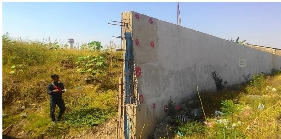
Gambar 4.87. Parapet sepanjang STA 3+600 hingga STA 2+550
