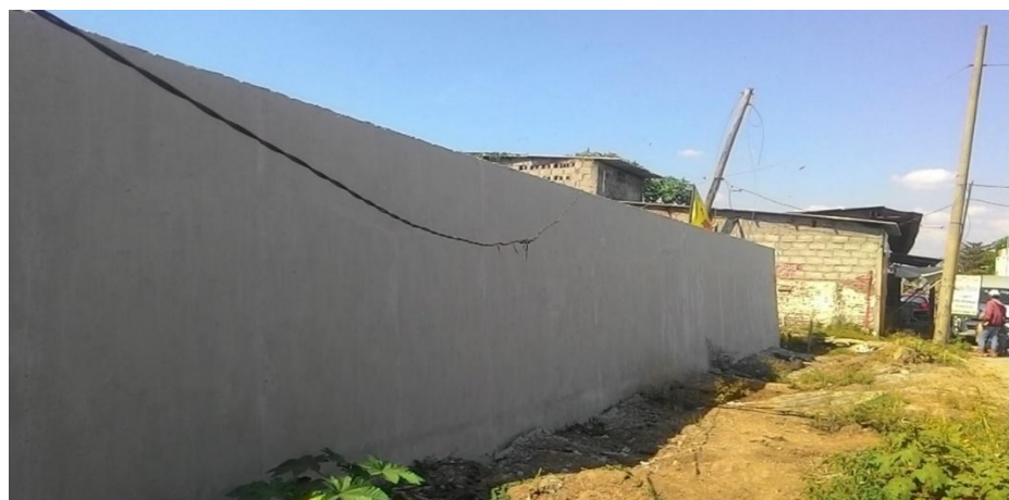
Gambar 4.88. Parapet sepanjang STA 3+600 hingga STA 2+550
