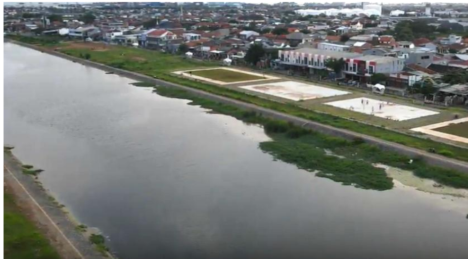
Gambar 4.78. Area Sedimentasi STA 3+200
