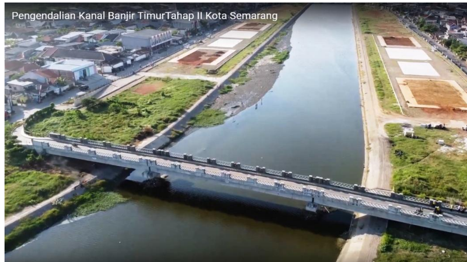
Gambar 4.81. Area Sedimentasi STA 2+750
