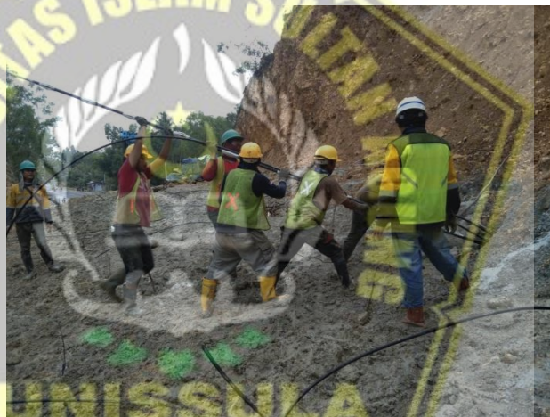
Gambar 2. 10 Proses Pemasukan Nail Bar ke dalam Lubang Bor
