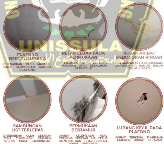
Gambar 2.9 Jenis Kerusakan Sedang Pada Plafond Sumber : Buku Pedoman Survei Kerusakan Bangunan
