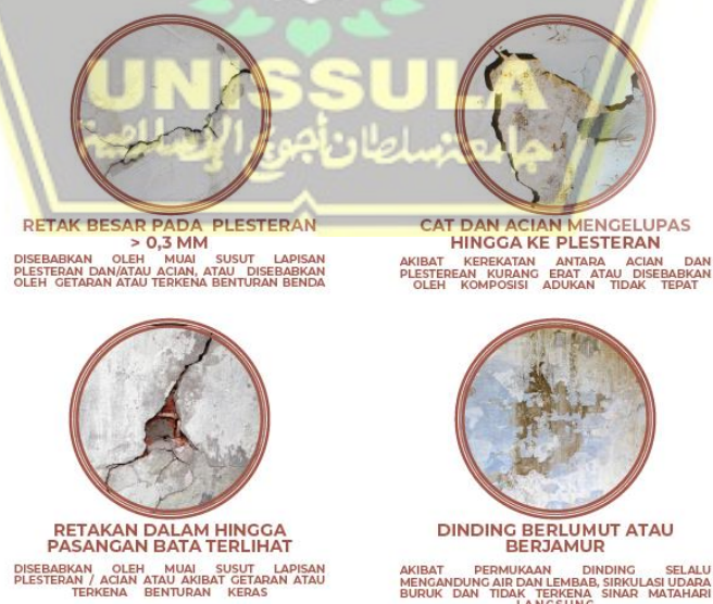
Gambar 2.7 Jenis Kerusakan Sederhana Pada Dinding Sumber : Buku Pedoman Survei Kerusakan Bangunan
