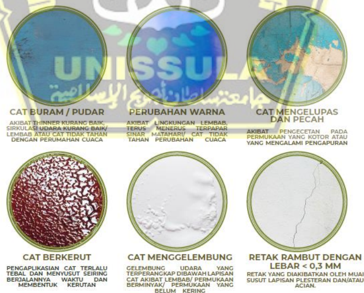
Gambar 2.3 Jenis Kerusakan Ringan Pada Dinding Sumber : Buku Pedoman Survei Kerusakan Bangunan
