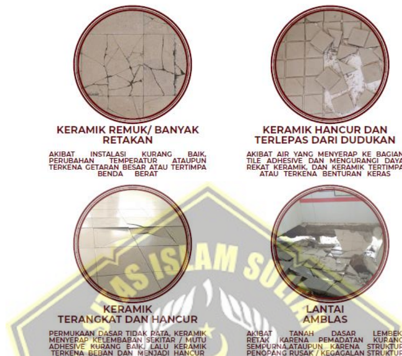
Gambar 2.14 Jenis Kerusakan Berat Pada Lantai Sumber : Buku Pedoman Survei Kerusakan Bangunan
