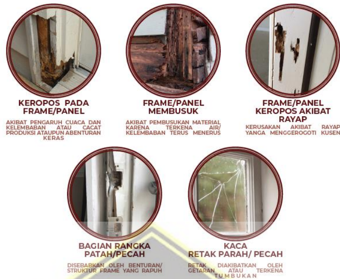
Gambar 2.12 Jenis Kerusakan Berat Pada Kusen Jendela dan Pintu Sumber : Buku Pedoman Survei Kerusakan Bangunan
