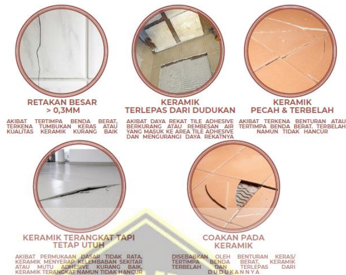
Gambar 2.10 Jenis Kerusakan Sederhana pada Lantai Sumber : Buku Pedoman Survei Kerusakan Bangunan
