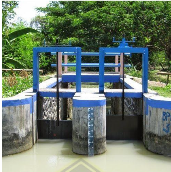
Gambar 2.3. Bangunan Pintu Air
