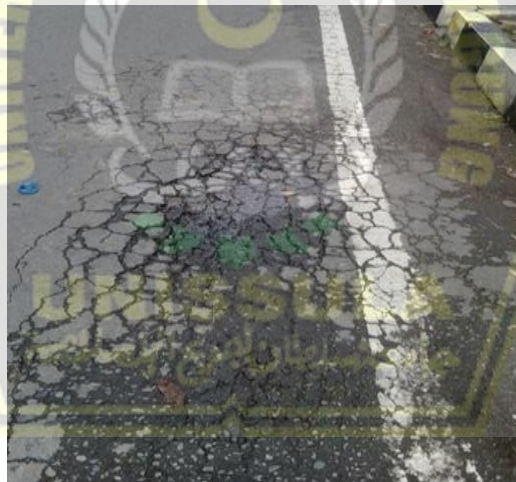
Gambar 2. 2 Retak Kulit Buaya
