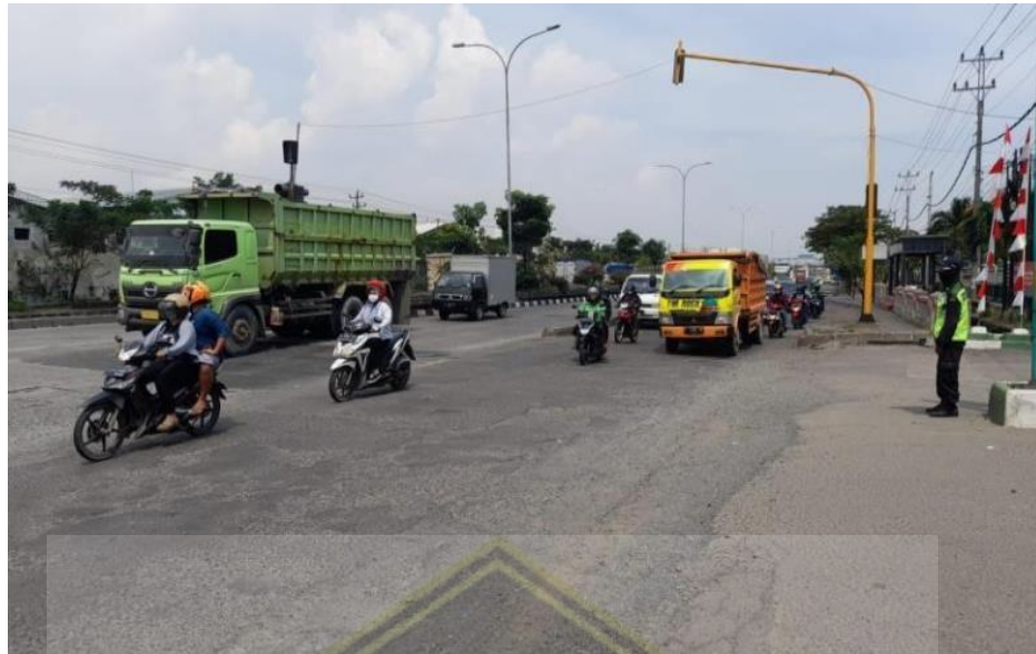
Gambar 4.2. Kondisi Simpang di Ruas Jalan Kaligawe Km.04
