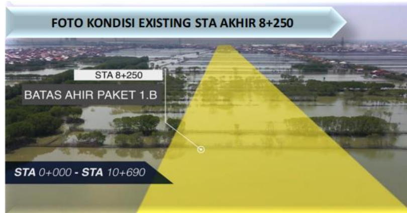
Gambar 4.4 Gambar Existing Lokasi Pekerjaan
