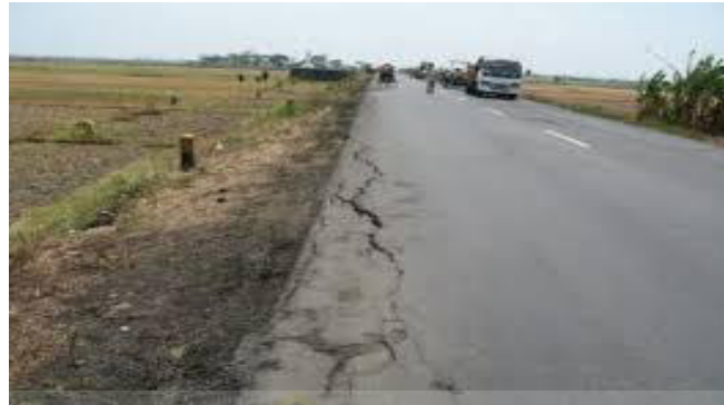
Gambar 2.4 Retak tepi
