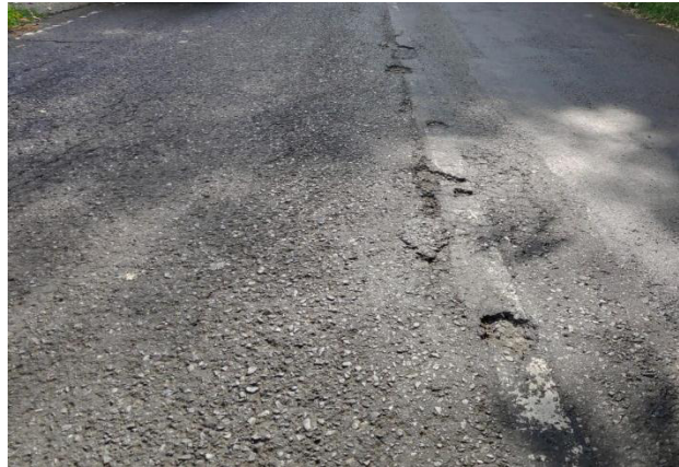
Gambar 4.9 Pengausan ( Polished Aggregate ) di ruas jalan Weleri – Patean ( Data Primer yang Diolah, 2022 )
