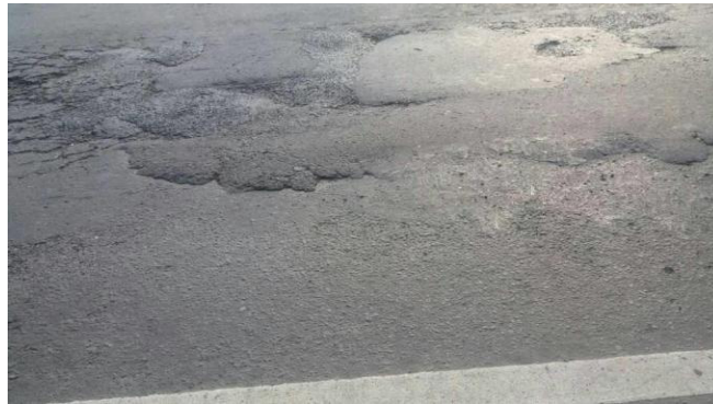
Gambar 2.20 Kegerukan ( bleeding or flushing )
