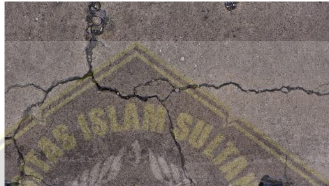
Gambar 2.9 Retak Susut
