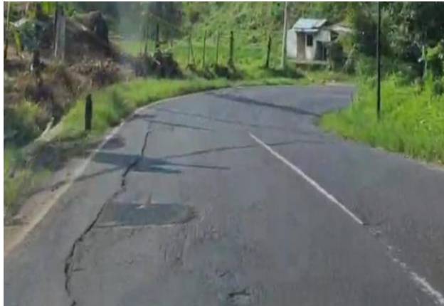
Gambar 4.5 Ambblas ( Grade Depressions ) di ruas jalan Weleri – Patean ( Data Primer yang Diolah, 2022 )
