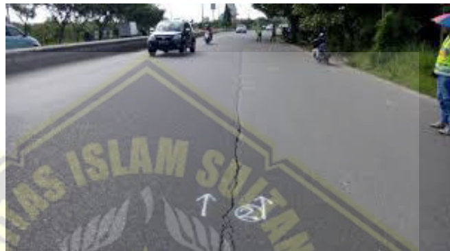
Gambar 2.1 Retak memanjang
