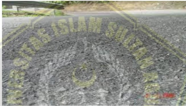
Gambar 2.18 Pengelupasan lapisan permukaan ( stripping )
