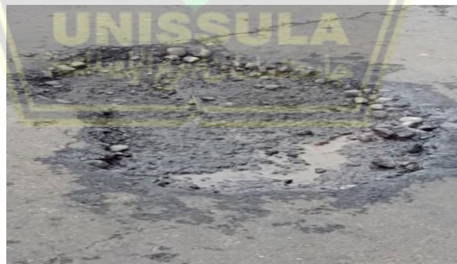
Gambar 2.17 Pelepasan butiran ( ravelling )
