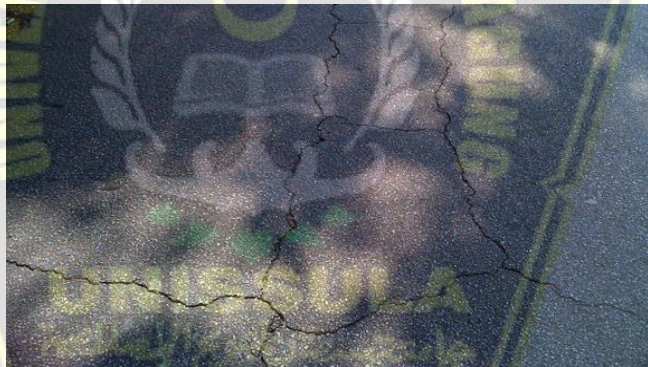
Gambar 2.3 Retak blok
