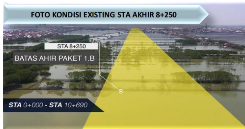
Gambar 4.4 Gambar Existing Lokasi Pekerjaan
