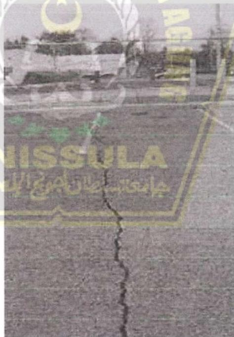
**Gambar 2. 10** Retak Memanjang atau Melintang
