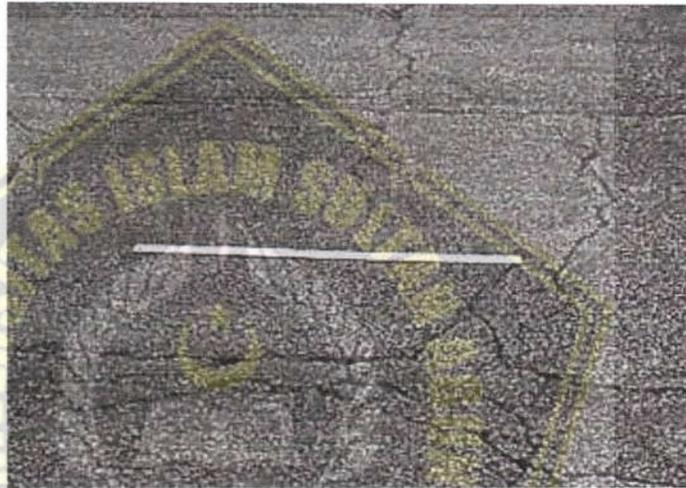
**Gambar 2. 6** Retak Blok
