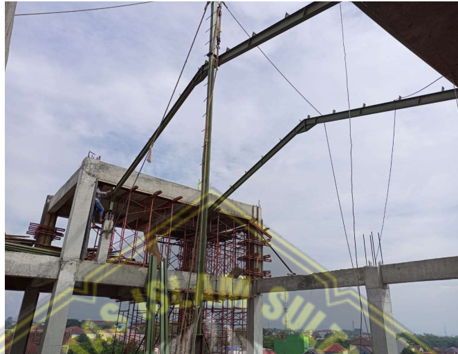
Gambar 4.13. Pekerjaan Rangka Atap
