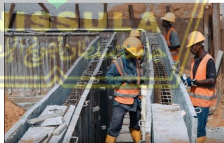
Gambar 4.34. Pembuatan Guide Wall
