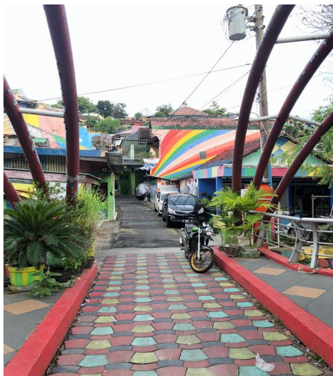
Gambar 4.3 Kondisi Jalanan yang ada pada Jembatan Sumber: Hasil Survei, 2021
