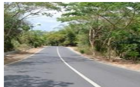
Jalan Strategis Nasional; Rencana Pembangunan Bypass Bandara-KEK Mandalika
