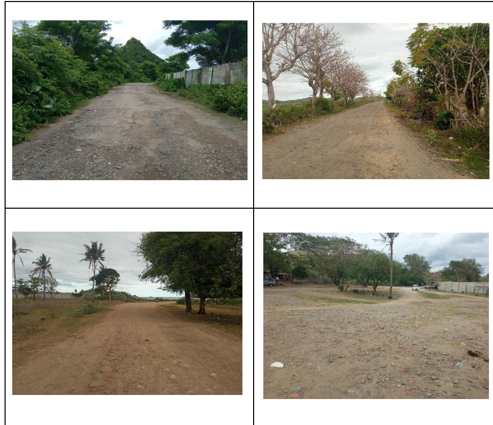
Gambar 3. 14 Kondisi jalan Pantai Tanjung Aan
