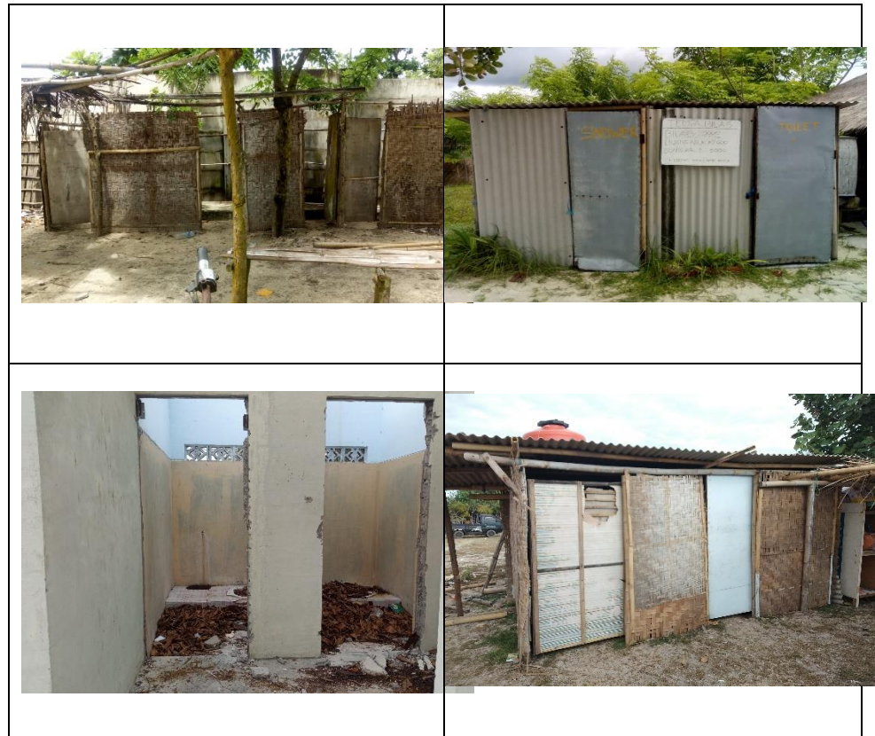
Gambar 3. 15 Kondisi toilet atau ruang ganti Pantai Tanjung Aan
