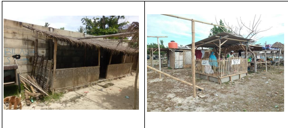
Gambar 3. 11 kondisi musholla yang ada di Pantai Tanjung Aan
