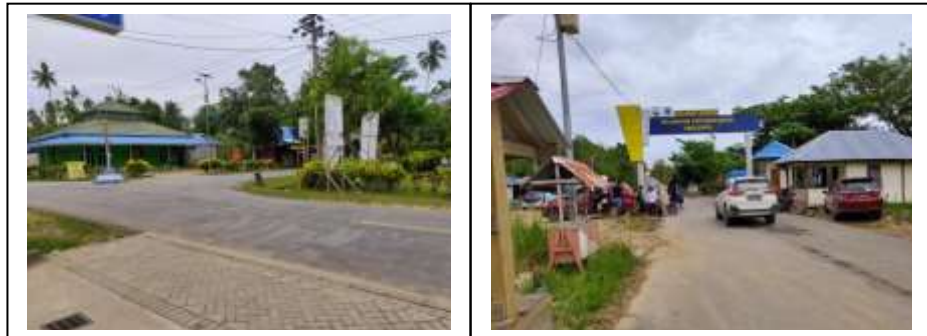
Gambar 3. 9 Kondisi jalan menuju pelabuhan Amolengu
