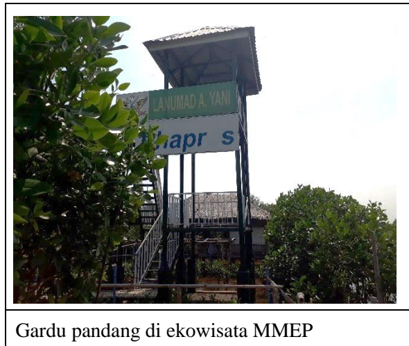
Gambar 4. 6 Ketersediaan dan Kondisi Gardu Pandang
