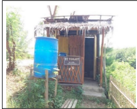
Kondisi toilet yang ada di ekowisata MMEP
