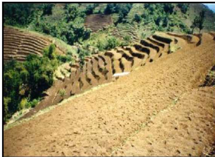
Gambar 4.9 Contoh Teras Bangku yang belum ditanami Tanaman Penguat Teras
