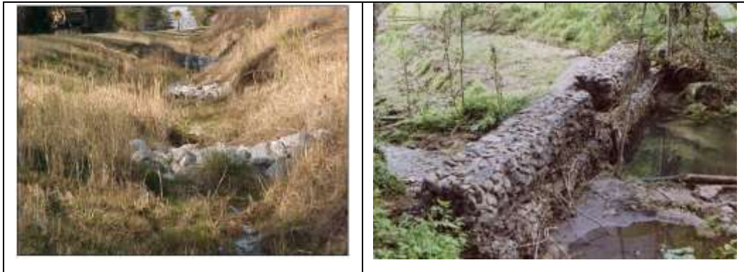
Gambar 4.10 Desain Cekdam Sederhana dengan Material Bronjong
