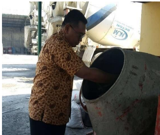
Gambar 4. 6. Pengadukan beton dengan Mixer
