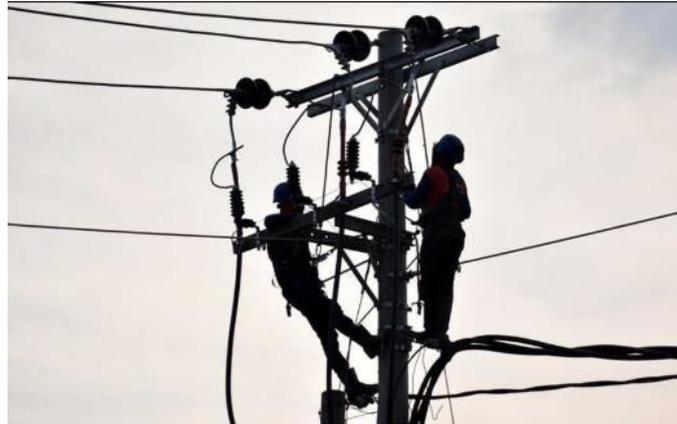
**Gambar 2.13 Saluran Kabel Udara Tegangan Menengah**
