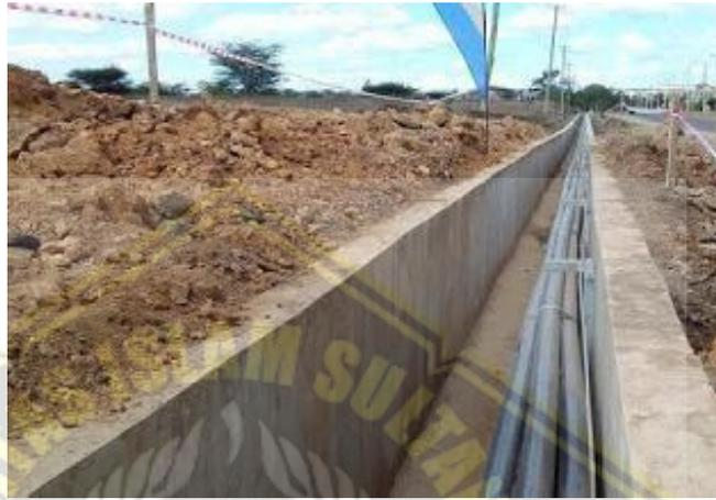
**Gambar 2.12 Saluran Kabel Tegangan Menengah (SKTM)**
