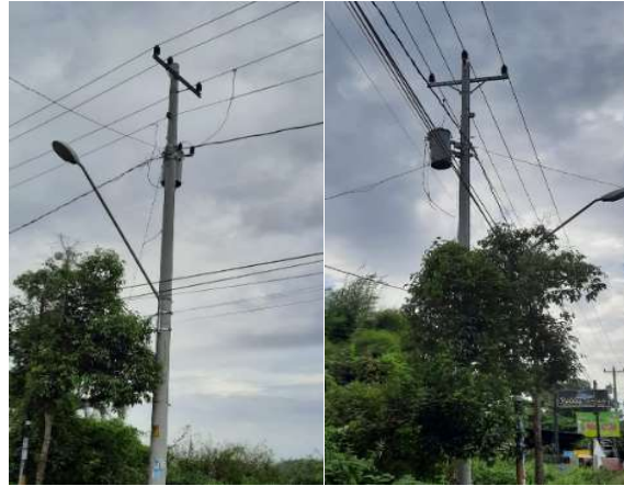
Gambar 4.16 Sambungan Trafo 1 Phasa Pada Jalur Utama 20 kV
