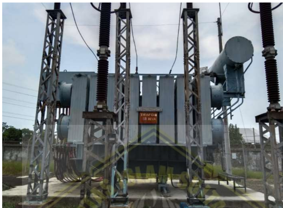
Lampiran 3 : Trafo Tenaga 60 MVA
