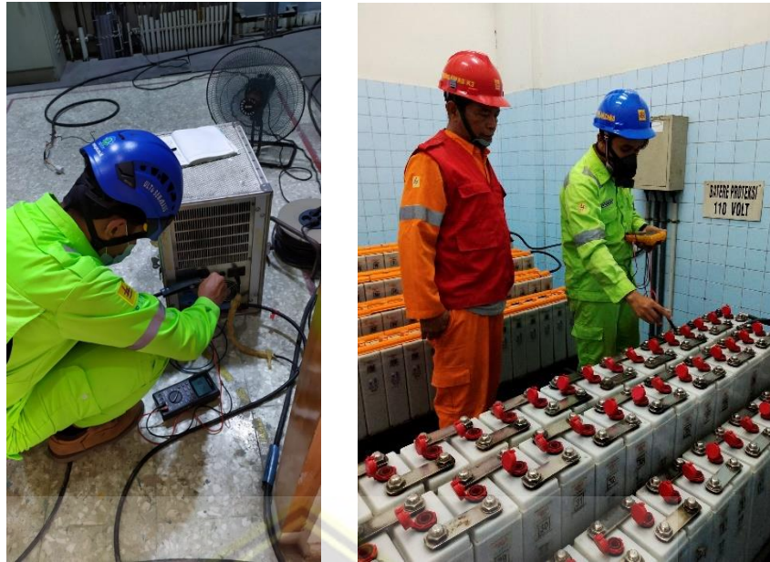
Gambar 4. 3 Pengukuran Sel Baterai Saat Proses Pengujian Discharge
