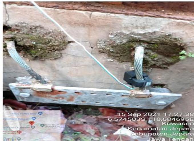
Gambar 3.11 Penempatan sensor arus PZEM-004T pada tower 14JPA010
