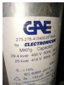
Gambar 4.1 Spesifikasi Kapasitor Bank Terpasang
