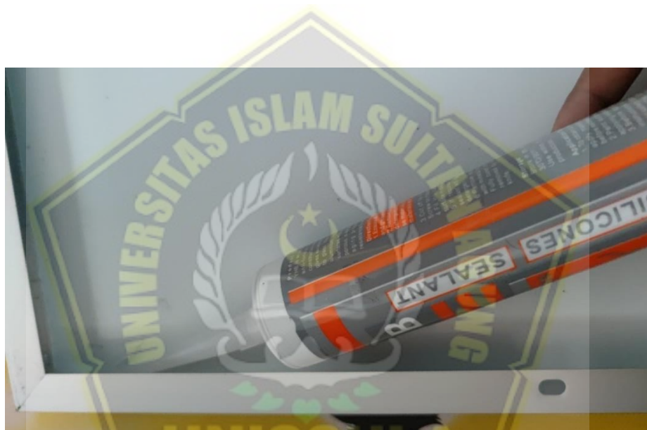
Gambar 3. 15 penambahan sealant pada panel surya
