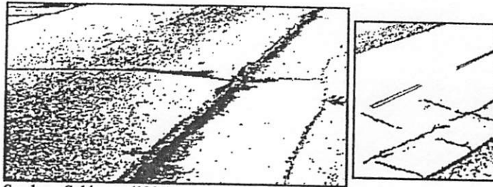
Gambar 2.7 : Kerusakan Jalan Retak Refleksi
