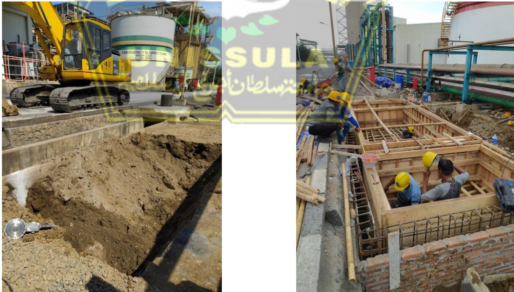
Gambar 1.1 Pekerjaan Proyek Instalasi Pompa Submersible di PT Komipo Pembangkitan Jawa Bali
