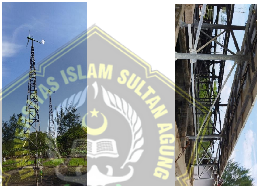
Gambar 4.2 konstruksi baja modul pembangkit
