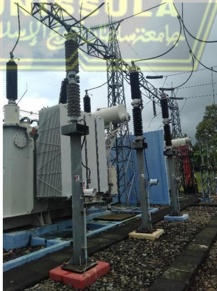
Gambar 2.21 Struktur Penyangga Lightning Arrester
