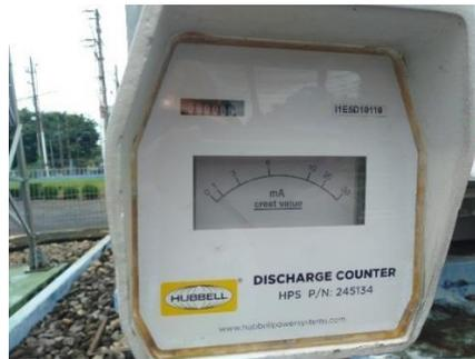
Gambar 2.19 Counter LA dan Counter dan Meter Arus Bocor Total LA
