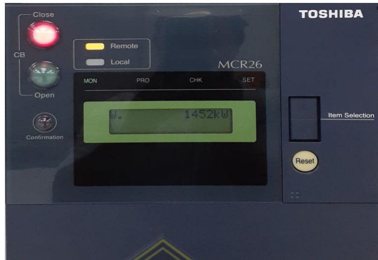
Gambar 4.4 Tampilan Daya Motor PAF pada Panel Listrik
