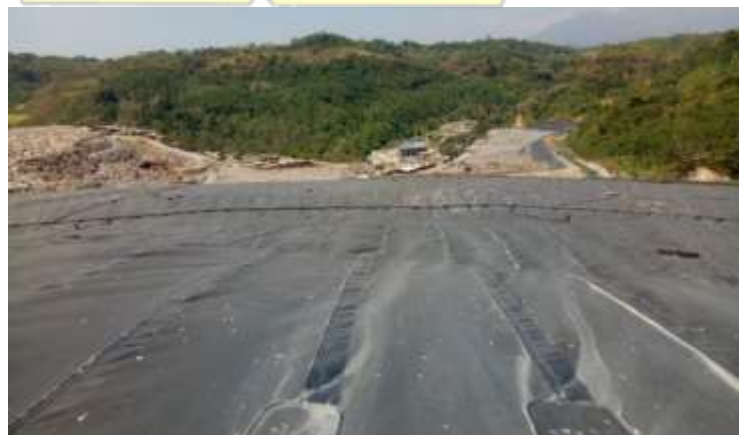
Gambar 2.5 Instalasi Pemipaan Landfill (25)
