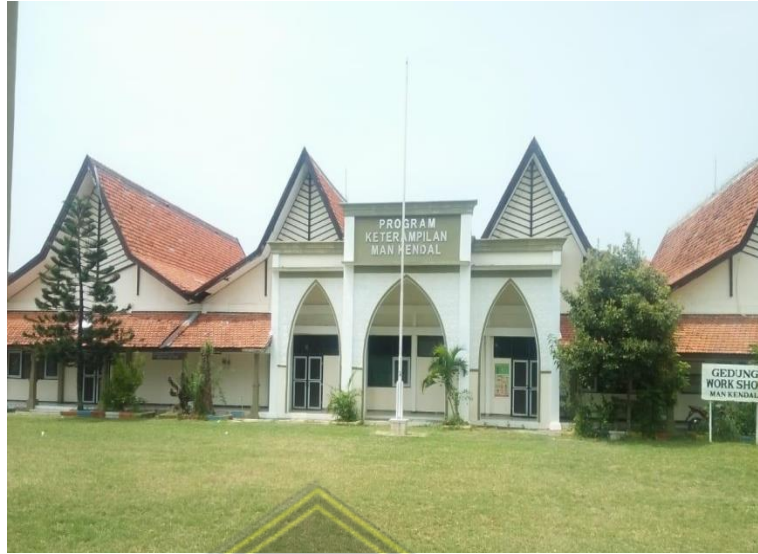
Gedung Workshop MAN utara
