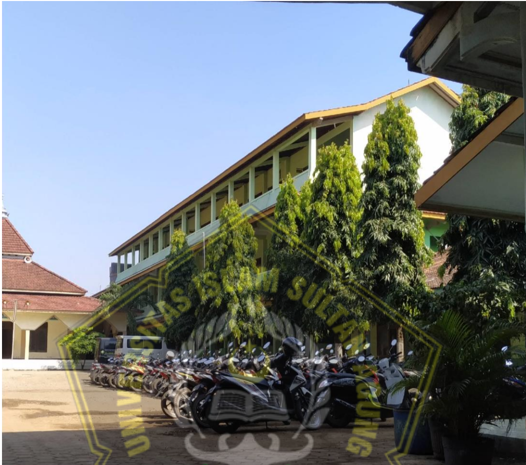
Keterangan : Gedung MTs Darun Najah Pati
