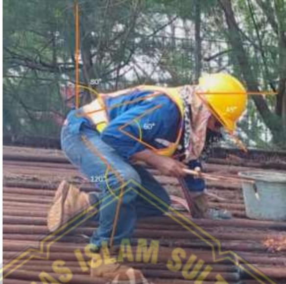
**Gambar 4.6** Pekerja melakukan pemotongan pipa scrap dengan posisi jongkok
