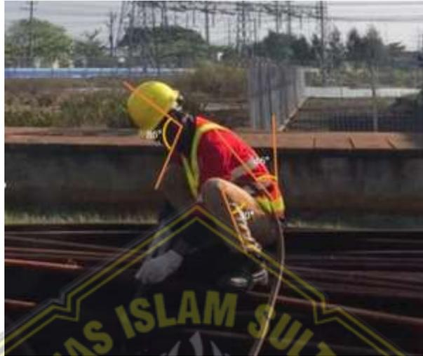
**Gambar 4.19** Pekerja melakukan pemotongan pipa scrap dengan posisi duduk
