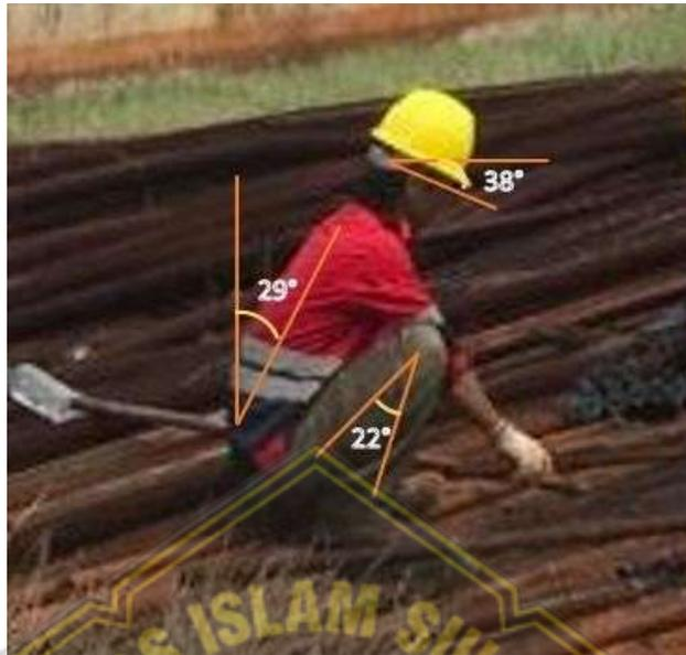
**Gambar 4.7** Pekerja melakukan pemotongan pipa scrap dengan posisi jongkok
