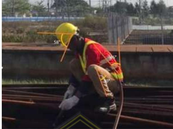
**Gambar 4.8** Pekerja melakukan pemotongan pipa scrap dengan posisi duduk
