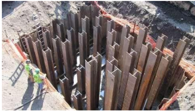
Gambar 2.8 Fondasi Tiang Baja Profil (rumah.com, 2020)
