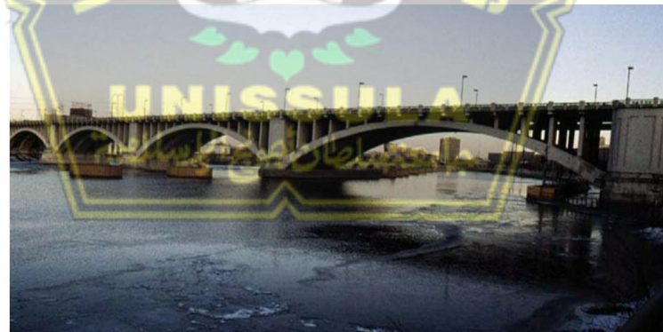
Gambar 1.1d. Jembatan Pelengkung Beton
