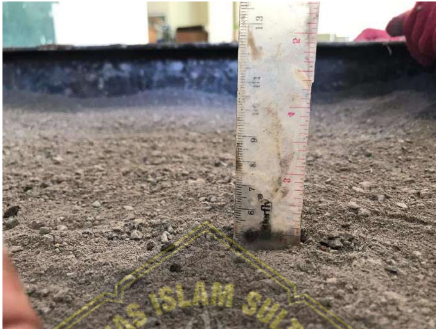
Pengukuran ketebalan pasir
