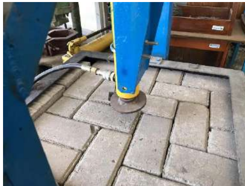
Gambar 3.7 Pemasangan paving holland
