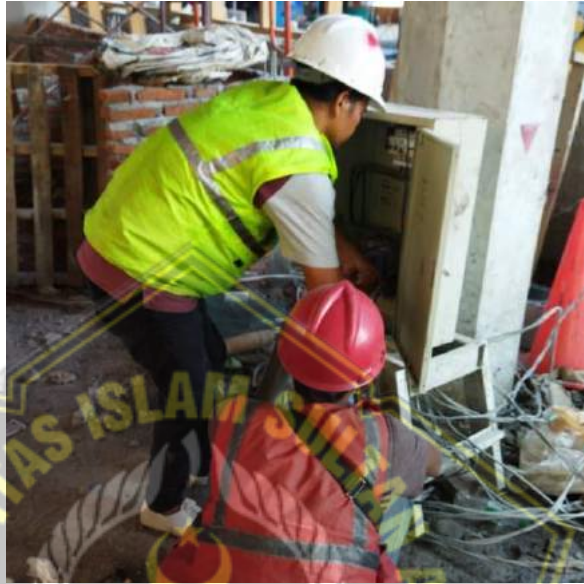
Gambar 4.10 Pengecekan Instalasi Listrik
