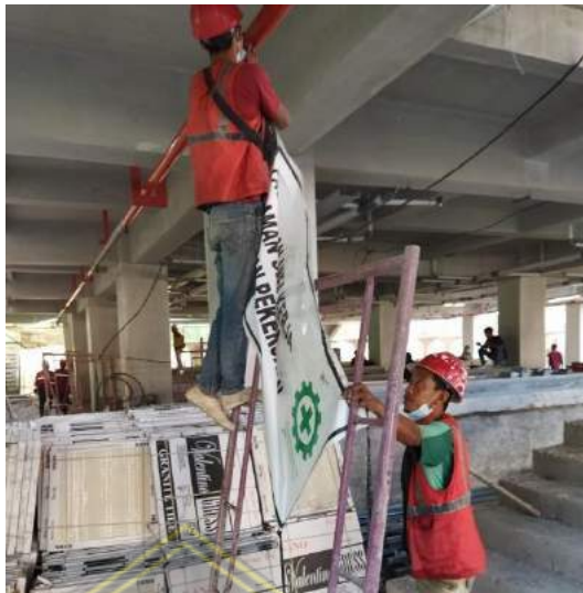
Gambar 4.8 Pemasangan Rambu-Rambu K3
