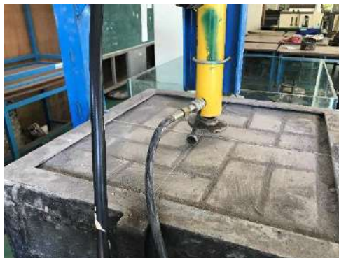
Gambar 3.9 Pemasangan benang diatas permukaan paving
