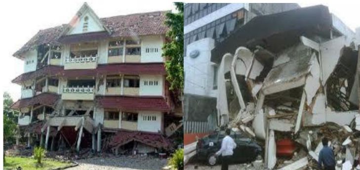
Gambar 2.1. Kerusakan Akibat Gempa
