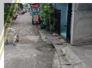
Saluran Drainase Lingkungan RT04-RW24, dengan kondisi saluran tertutup dan tidak tersumbat serta terhubung dengan Kali Anyar
