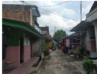
Jalan Lingkungan RT 7 – RW 18, dengan kondisi jalan tidak rata dengan lebar 2 meter dan berkontruksi beton, serta bahu jalan dipenuhi bangunan permukiman
