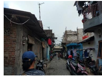
Jalan Lingkungan RT 1 – RW 24, dengan kondisi jalan rata dengan lebar 1,5 meter dan berkontruksi paving, serta bahu jalan dipenuhi bangunan permukiman
