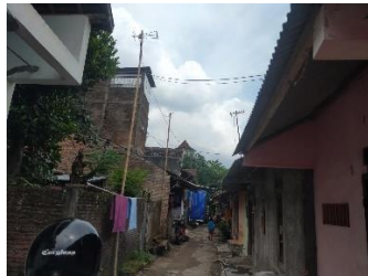
Jalan Lingkungan RT 2 – RW 13, dengan kondisi jalan tidak rata dengan lebar 2 meter dan berkontruksi beton, serta bahu jalan dipenuhi bangunan permukiman
