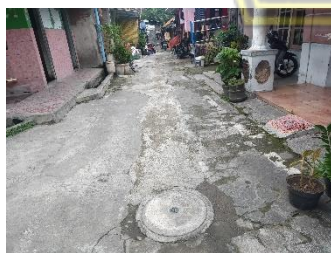
Saluran sanitasi lingkungan RT 3 – RW 13, yang terletak di bawah jalan lingkungan dan tanda tutup lingkaran dengan kondisi baik dan terawat.
