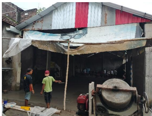
Gotongroyong masyarakat RT 1 – RW 24 dalam pembangunan gedung serba guna
