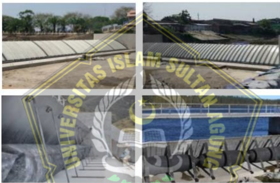
Gambar 2.5. Contoh Konstruksi Bendung Karet Berpelindung Baja di Kali Anyar/ Kali Pepe Surakarta (Balai Besar Wilayah Sungai Bengawan Solo, 2016)
